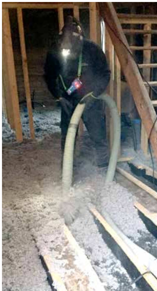
Här isoleras ett golvbjälklag med cellulosa fibrer från dagstidningar.
